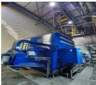
L'énergie dégagée par la combustion des déchets sous forme de vapeur surchauffée alimente un turboalternateur qui a produit 105 367 MWh d'électricité en 2024.
