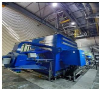
**L'énergie dégagée par la combustion des déchets sous forme de vapeur surchauffée alimente un turboalternateur pour produire 100 000 MWh/an d'électricité.**
